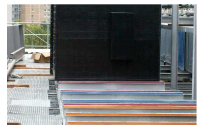
Bild 1: Underhållsfri uppställning med Isotop DSD
